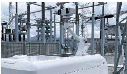
IR-Inspektion in Kraftwerken
